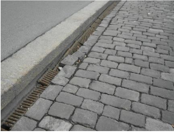
Defekte Entwässerungsrinnen
