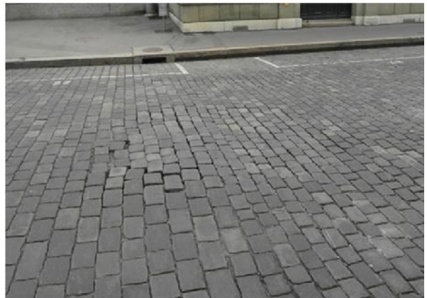
Deformierte Pflasterung
