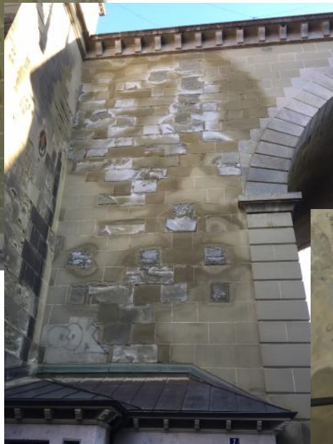
Durchnässte Gewölbe und Seitenwände
