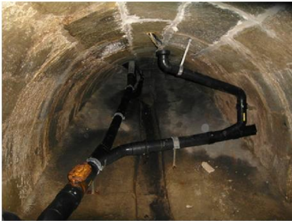
Wassereinbrüche und undichte Entwässerungsleitungen in den Innengewölben
